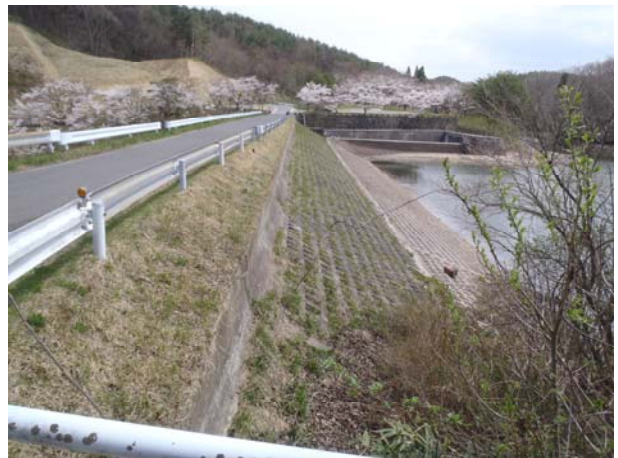
堤裏変状無し
