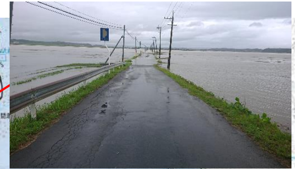
吉田川(左岸)12.5k 品井沼遊水地付近
